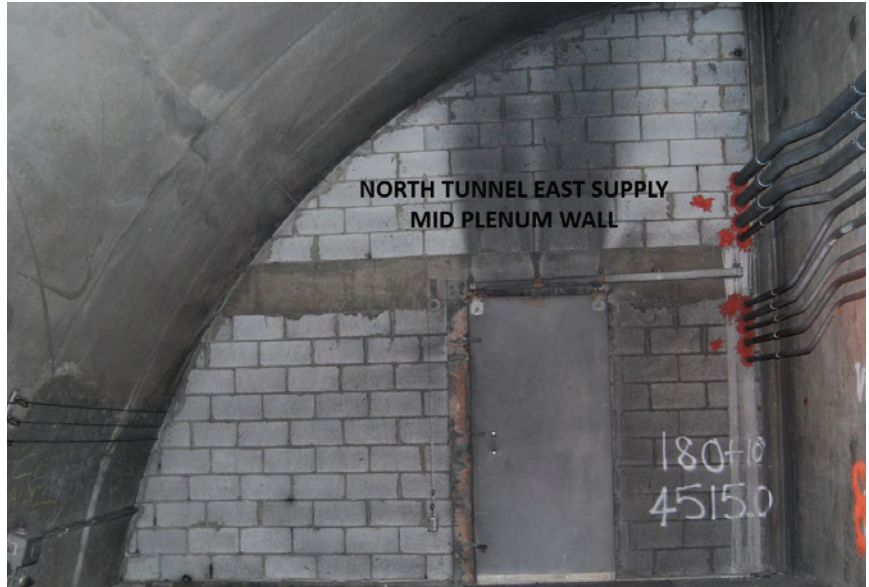
Mid Plenum Wall
